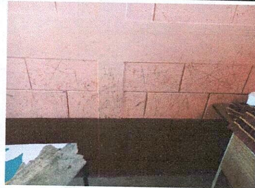
Foto 2: PINTURA EN AULAS, INTERIOR Y EXTERIOR.
