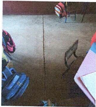
Foto 3: CAMBIO DE PISO EN AULAS.
